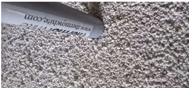
Probenentnahme mit einem Rohr aus der Dämmschüttung.
