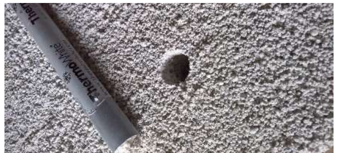
Entnahmestelle in der Dämmschicht.
