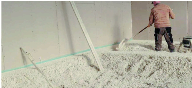
Wandanschluss mit Dampfbremse aus der Originalunterlage.
