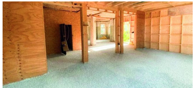
Dämmschüttung im Innenraum eines Holzbaus.
