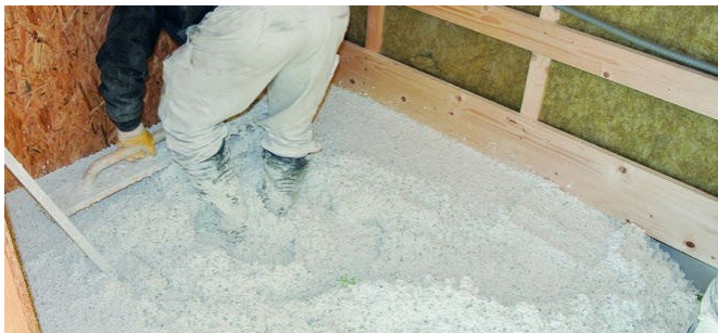
Einbau der Dämmschüttung in einer Holzdeckenkonstruktion.
