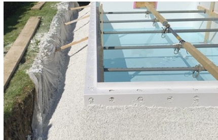
Formung und Verdichtung des eingebrachten Materials.
