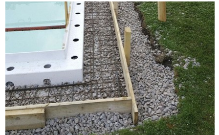
Vorbereitung für den Betonring am Beckenrand.
