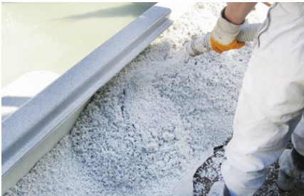
Einbringung über das ThermoWhite® Mixmobil.
