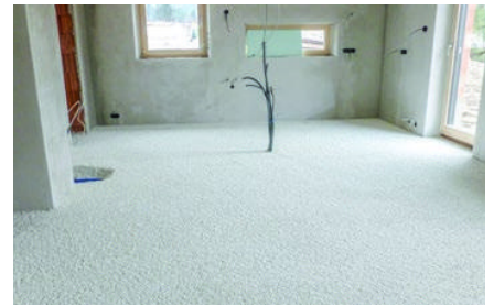
Flächen abziehen; Unebenheiten oder Vertiefungen ausgleichen.
