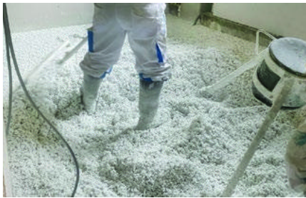
Das Material im Raum verteilen und auf das Höhenniveau einrichten.
