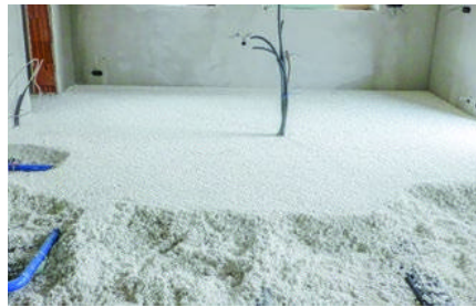
Aufgetragene Flächen vollflächig verdichten.
