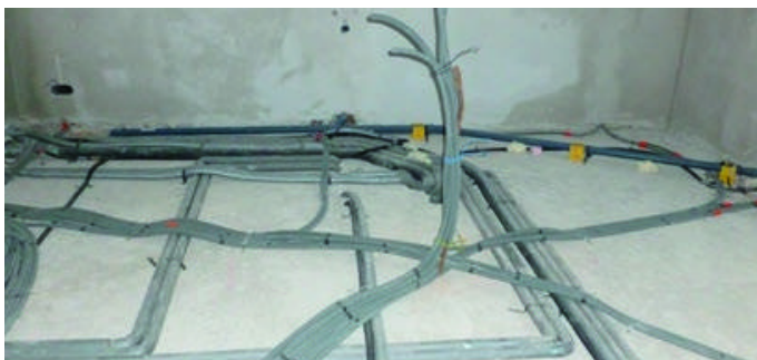
Leitungen am Boden befestigen.
