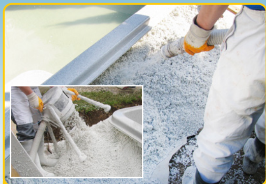
Einbringung der Pooldämmung über das ThermoWhite-Mixmobil
