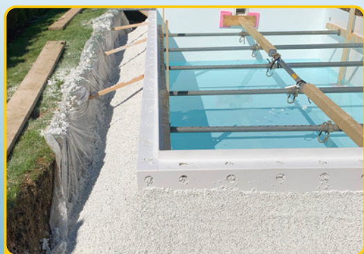
Formung und Verdichtung des eingebrachten Materials
