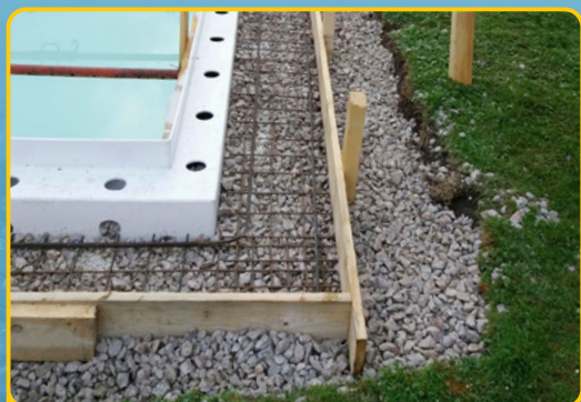
Vorbereitung für Betonring am Beckernrand
