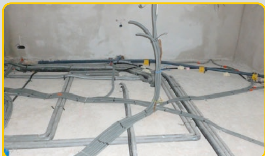
Leitungen am Boden befestigen
