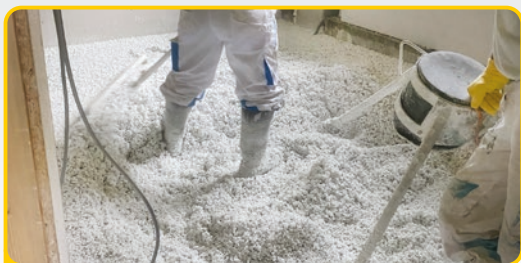
Mittels Auslaufbock verteilen und auf die Höhe einrichten
