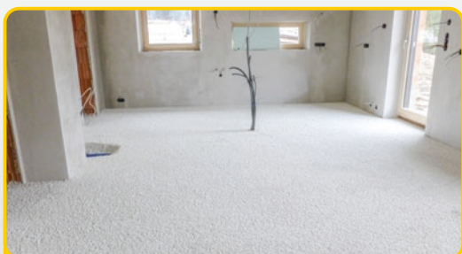
Flächen abziehen. Unebenheiten oder Vertiefungen ausgleichen
