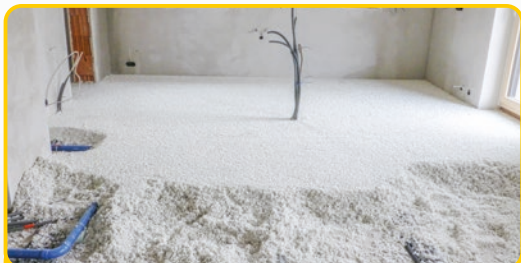
Aufgetragene Flächen vollflächig verdichten
